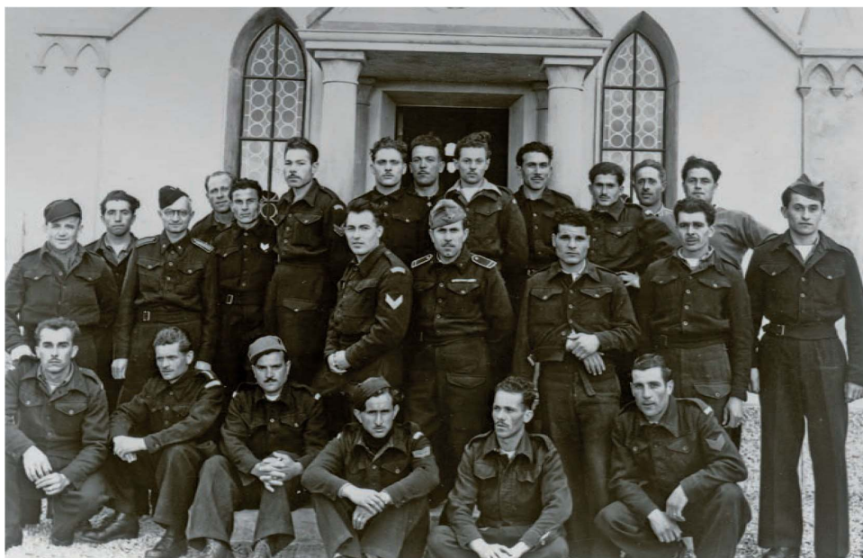
Gli uomini che costruirono la cappella. Chiocchetti (in piedi all'estrema sinistra), Palumbi (davanti al pilastro di sinistra)
